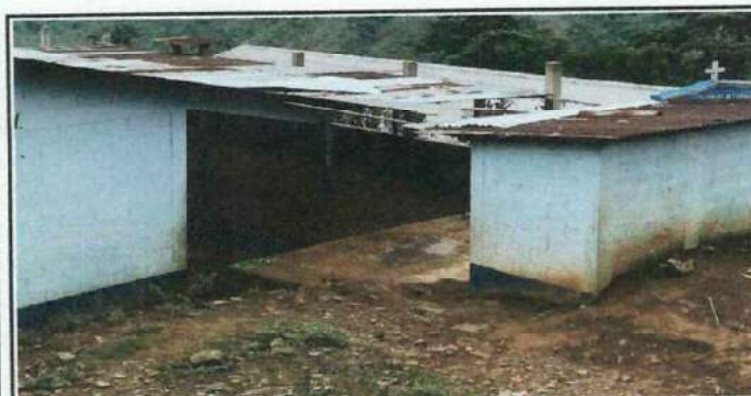
Foto 5: Deterioro de pinturas en las paredes de las aulas y del entechado del establecimiento.
