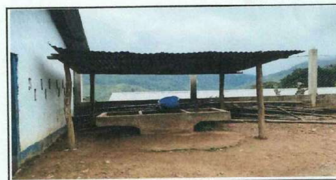
Foto 6: Pila en mal estado. Se requiere modificación de pileta para uso general de la comunidad educativa.
