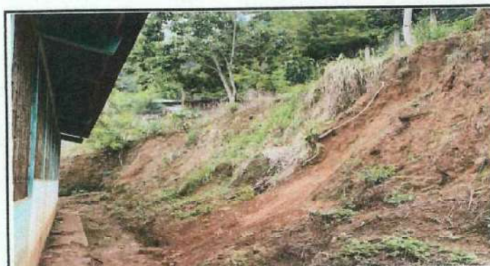
Foto 4: Mejoramiento de cunetas.
