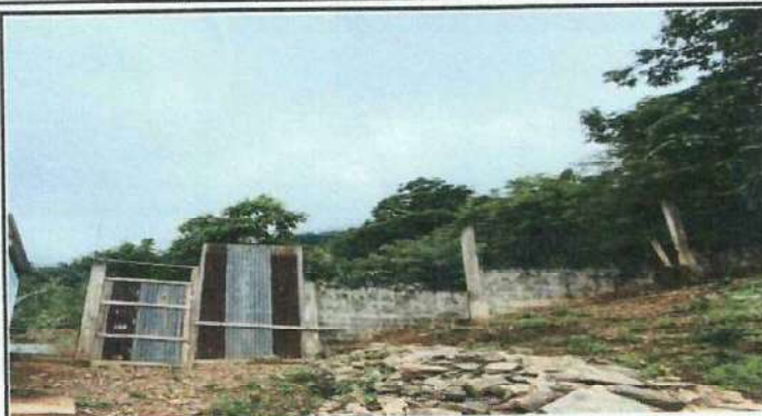
Foto 2: Mejoramiento de porton.
